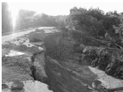
泥流・土石流による道路寸断
