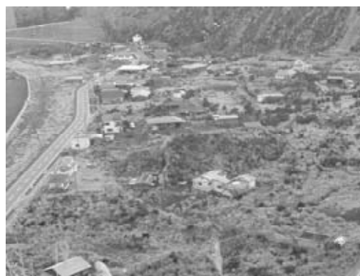
高濃度地区の被災家屋(2010年撮影)
