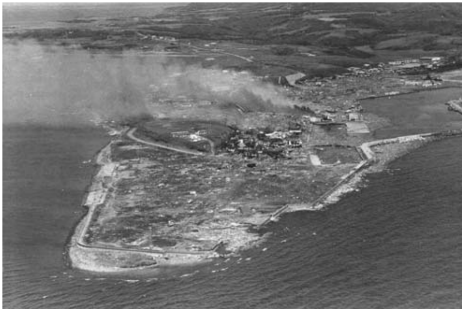
資料4 北海道南西沖地震津波により変わり果てた町並み（青苗地区）
