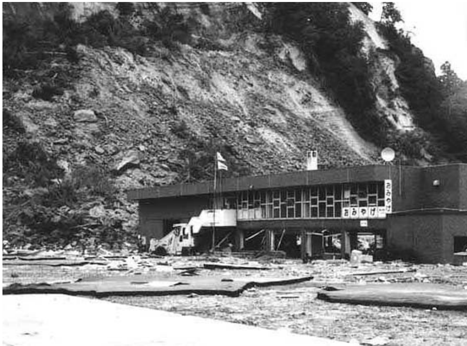
資料3 北海道南西沖地震による崩落現場3（奥尻地区）
