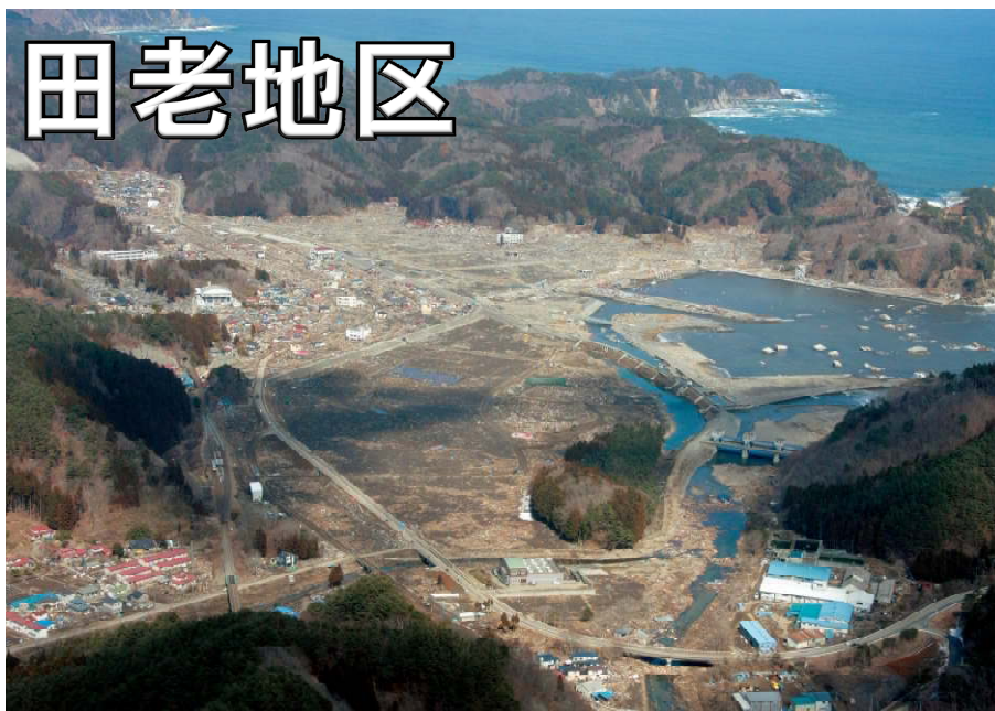
総延長2,433m、海面からの高さ10mの防潮堤も今回の津波にはなすべがなかった
