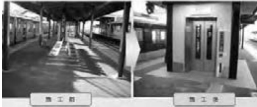
近鉄向島駅 エレベーターの設置
