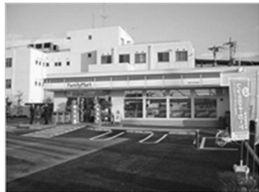
写真 3-4-1 秦野市庁舎敷地内のコンビニエンスストア
