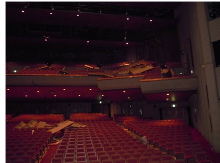
(2011.3.11福島県民ホール天井落下)
