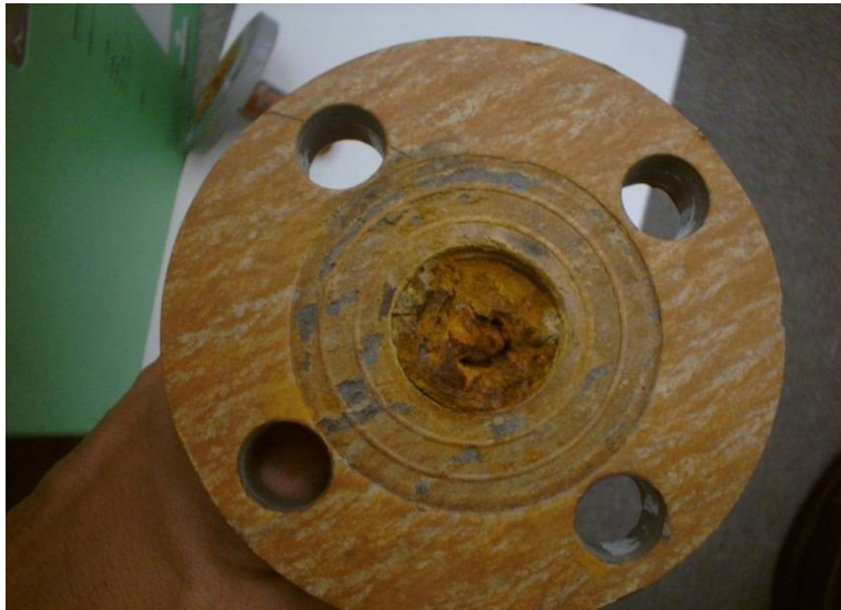
建築後10数年の給排水管の 閉塞状況
