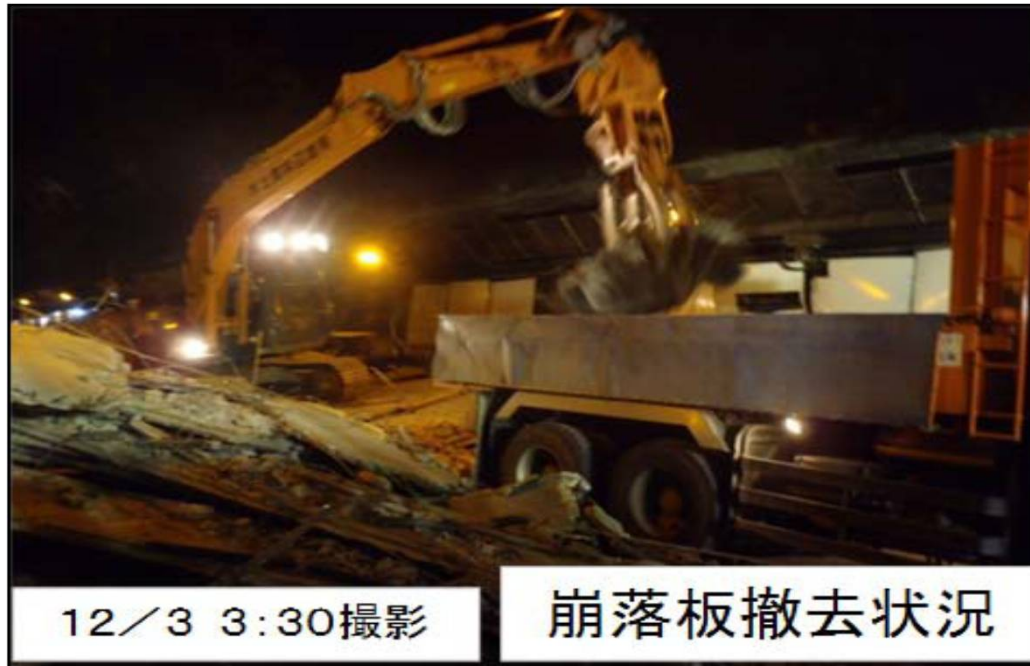
(2012.12.2中央道笹子トンネル天井板落下事故)
