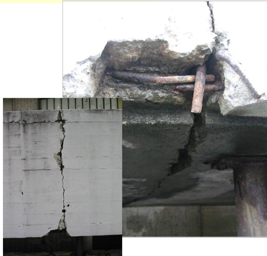
コンクリートの爆裂 （経年劣化、施工不良）
