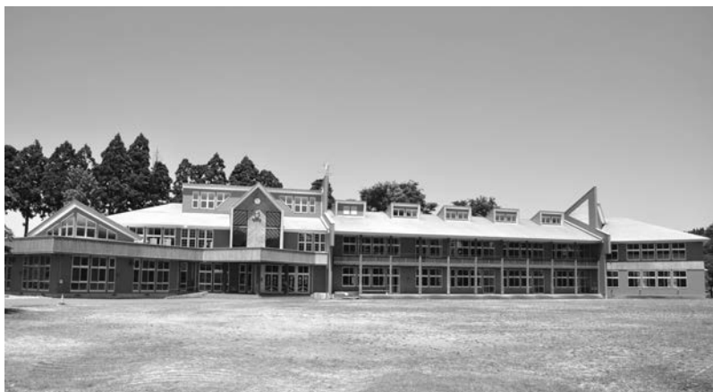
写真1-4-1 五城目町地域活性化支援センターの外観
