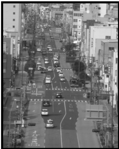
図 2-3-9 BRT の導入状況（バスレーンのカラー舗装化） 出典：岐阜市撮影
