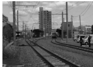
線路の接続部分
