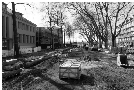
写真1：2015年工事中 (2015年当時は、エピ島でトラムの延伸工事の真っ最中であった)
