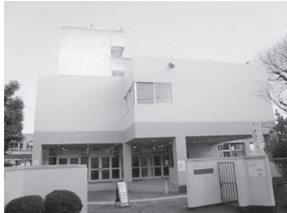
写真8 事例②／たちかわ創造舎(多摩川小)
