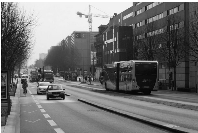
図 2-2-10 ナントのBRTと沿線環境
