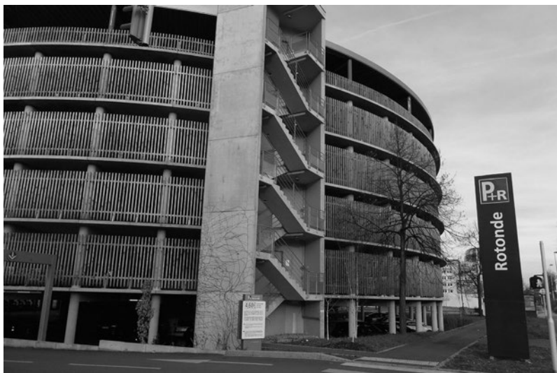
図 2-2-7 ストラスブールのトラム停留所に隣接するパークアンドライド駐車場
