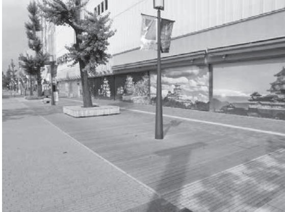
写真6 利活用空間として整備したウッドデッキ
