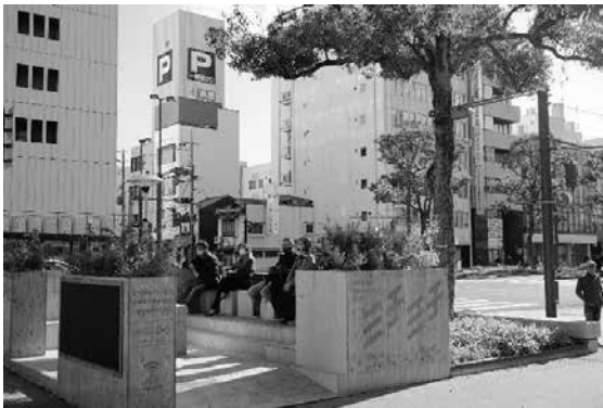
写真 15 実際に設置した構造物①
