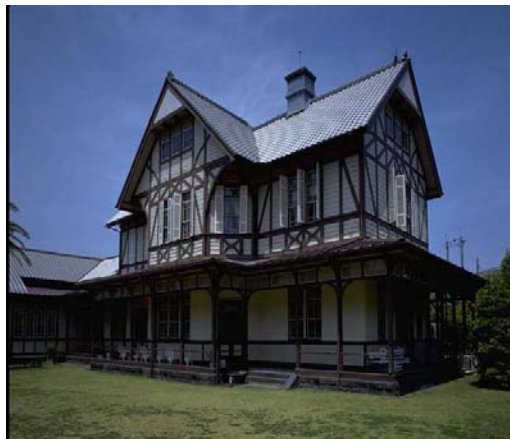
明治 41 年開館の旧三井港倶楽部 (写真提供：大牟田市)
