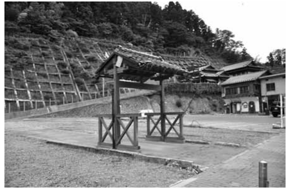
仮設商店街用地
