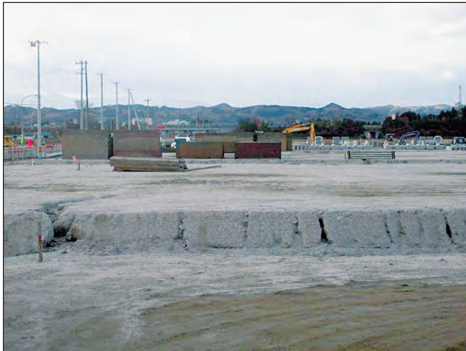
資料2 造成工事（高さ2メートルのかさ上げを実施）
