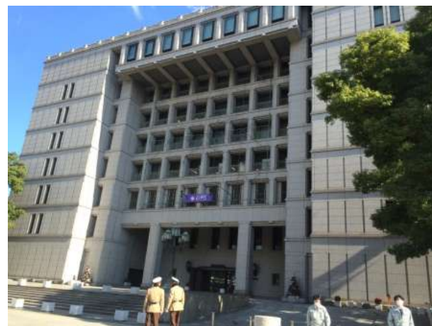
<大阪市本庁舎外観>
