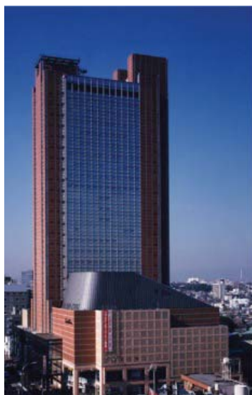
世田谷文化生活情報センター (キャロットタワー全景)
