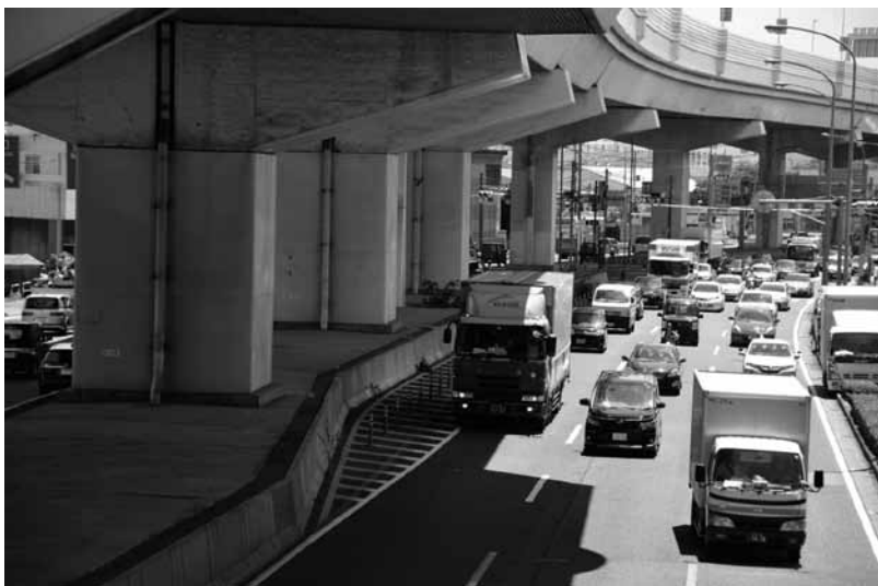
写真1-1 都市を分断する幹線道路
