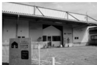
写真5-13 戸田市のリノベ倉庫
