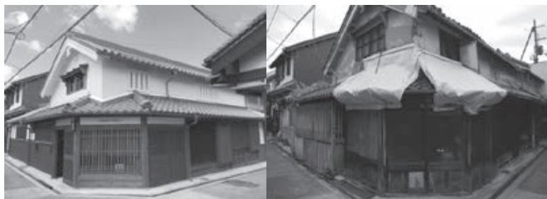
図 2-2-3 奈良医大今井町ゲストハウス外観(左:改修前、右:改修後)
