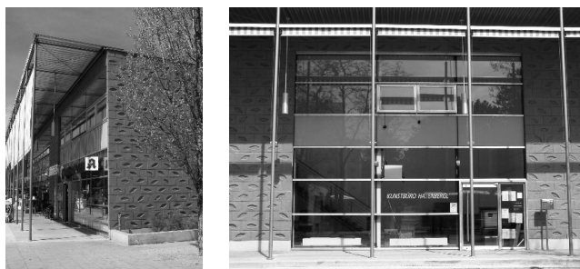
図 1-4-11 訓練生が制作した外壁
