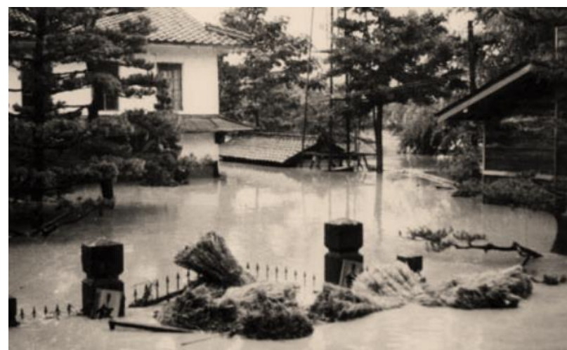
▲飯田市役所川路支所(旧川路村役場)が水没している様子 （川路水害予防組合）
