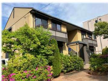
断熱改修を行う 既存賃貸集合住宅
